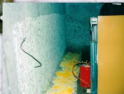
Dans l'arrière-cave, ce n'est pas mieux, il faut également décrépiter le mur et enlever une couche de 15 cm de terre sur le sol, mais on est en partie sur de le rocher, et il faut faire usage de barres à mine, de masses et de burins.
