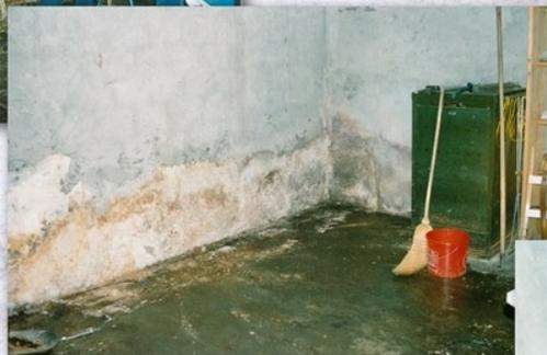
Le mur doit être décrépi et la dalle doit être cassée sur toute la longueur.
